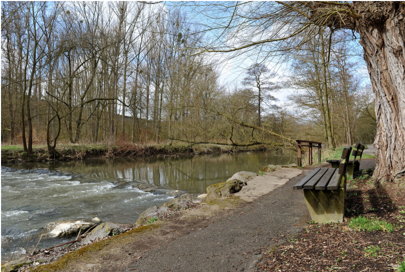
Bad Bodendorfer Wehr (2013) Fotograf/Urheber: Anton Simons
