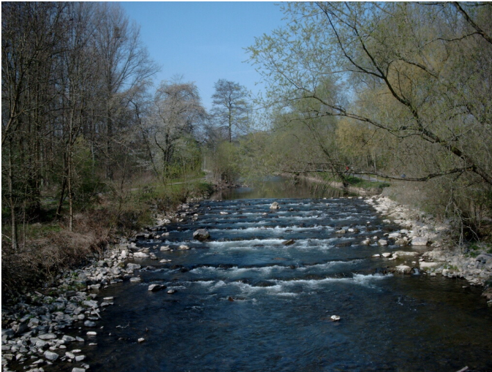
Blocksteinrampe am Bodendorfer Wehr (2001) Fotograf/Urheber: Elmar Knieps
