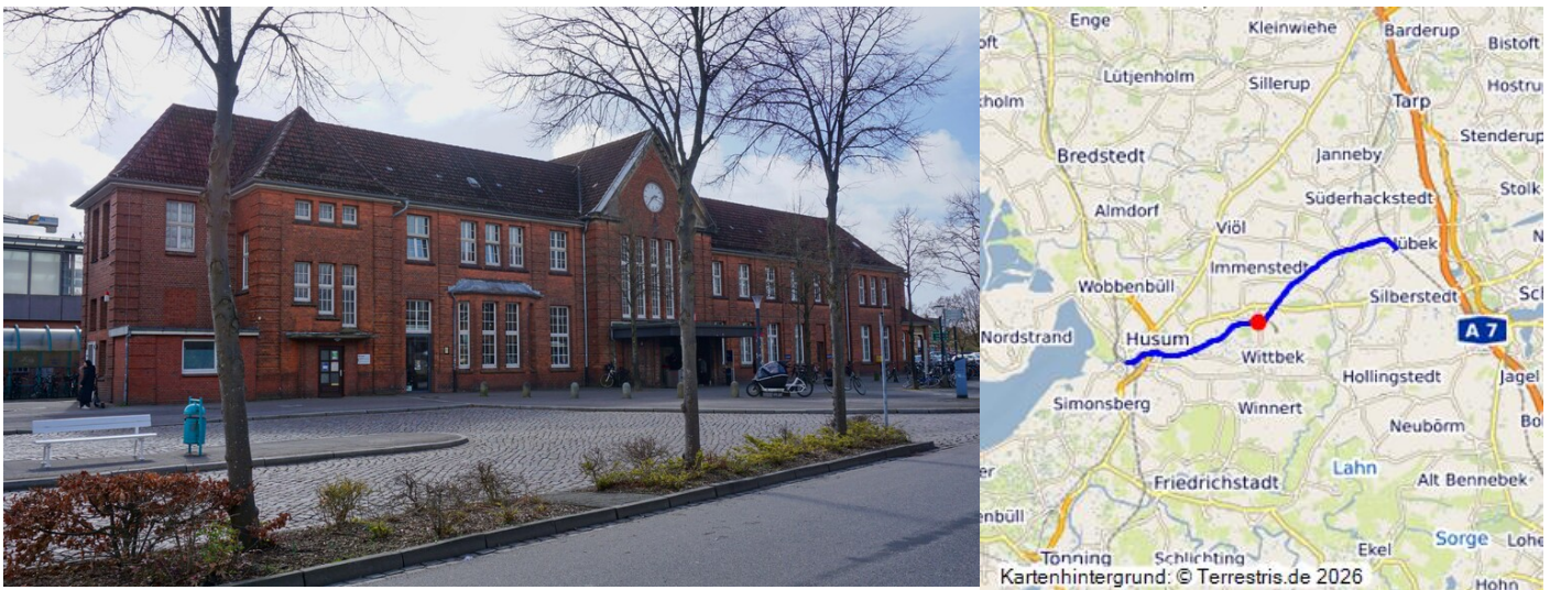
Bahnhof Husum (2026). Empfangsgebäude von 1910, Straßenseite Fotograf/Urheber: Claus Weber
