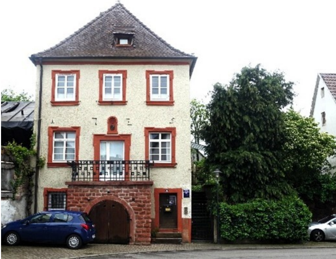
Rohrbacher Tor in Billigheim (2025) Fotograf/Urheber: Ralf Piepenbrink
