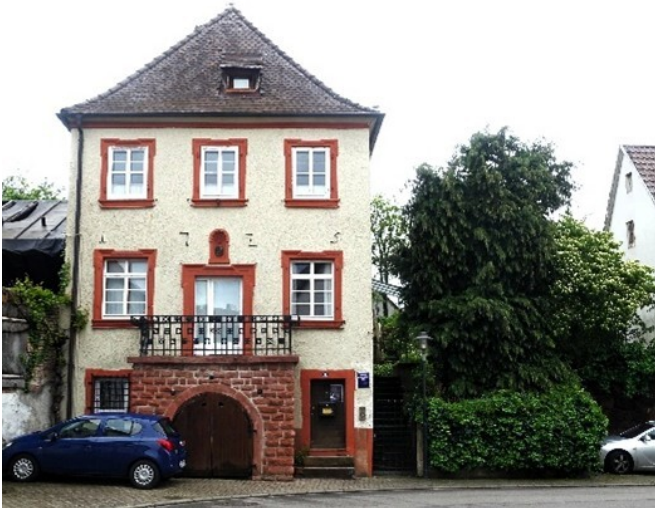
Rohrbacher Tor in Billigheim (2025) Fotograf/Urheber: Ralf Piepenbrink
