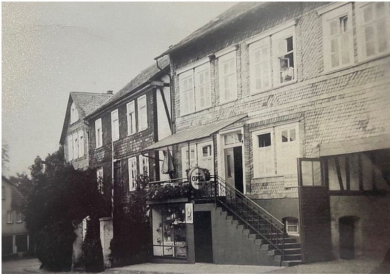
Das ehemalige Wohnhaus und die Stallungen von Moritz Herz in der Siegstraße 29 in Hamm (Sieg) (1950er Jahre) Fotograf/Urheber: unbekannt
