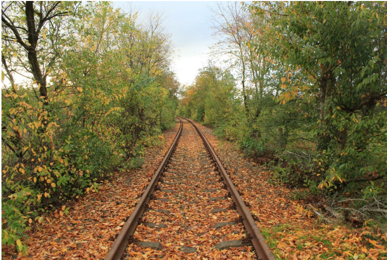
Bahnstrecke von Flensburg Weiche nach Lindholm. Trasse An der Wallsbek (2018) Fotograf/Urheber: Marseille77
