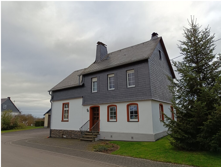
Schulgebäude in Forst (2024) Fotograf/Urheber: Grischa Manderscheid
