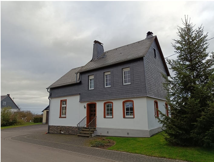
Schulgebäude in Forst (2024) Fotograf/Urheber: Grischa Manderscheid
