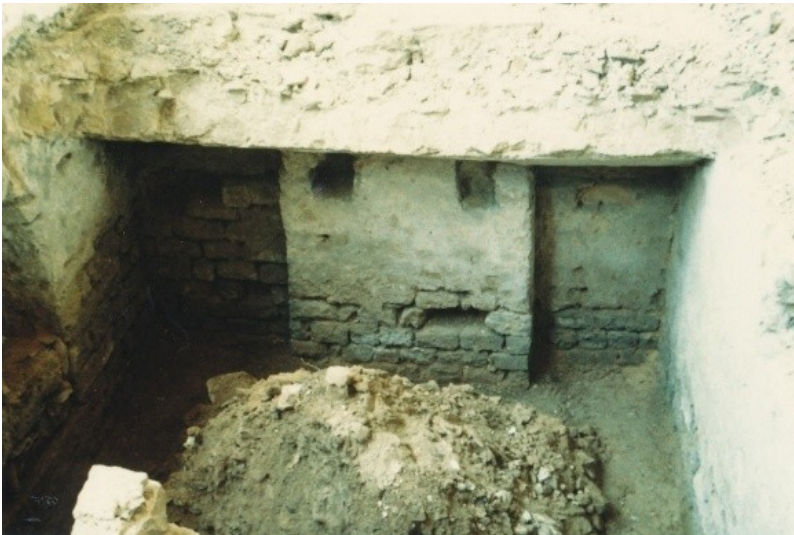
Billigheimer Grablege (ca. 1962) Fotograf/Urheber: Landesamt Denkmalschutz Speyer
