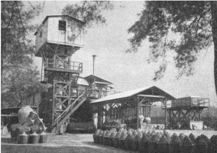
Anlage zur Denitrierung auf dem Gelände der Sprengstoff AG Carbonit in Schlebusch (um 1900). Fotograf/Urheber: Sprengstoff AG Carbonit
