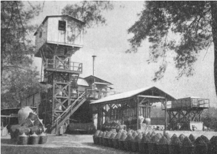
Anlage zur Denitrierung auf dem Gelände der Sprengstoff AG Carbonit in Schlebusch (um 1900). Fotograf/Urheber: Sprengstoff AG Carbonit
