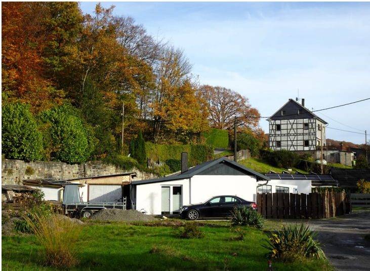
Tiefer Stollen und Zechenplatz der Grube Castor (2025). Fotograf/Urheber: Peter Schönfeld
