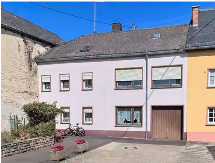
Boden-Haus Burgstraße 7 in Oberkail vor der Renovierung (2023) Fotograf/Urheber: Jörg Kreuz
