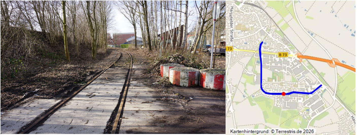
Anschlussbahn Ottenbeck (2026). Gleis in Höhe Carl-Goedeler-Weg Fotograf/Urheber: Claus Weber
