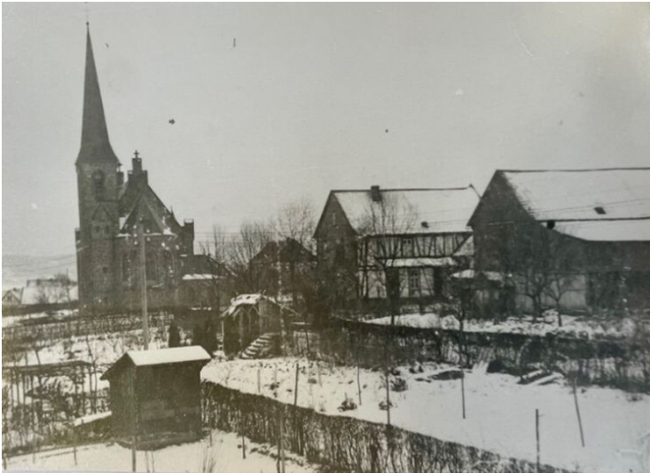
Blick auf das Haus Bachenheimer, vormals Hof Paul, in der Straße Ringelsmorgen in Hamm (Sieg) (1950er Jahre) Fotograf/Urheber: unbekannt
