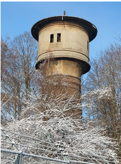
Ein Wasserturm der ehemaligen Dynamitfabrik Wahn auf der Linder Höhe in Köln-Lind (2026). Fotograf/Urheber: Franz-Josef Knöchel
