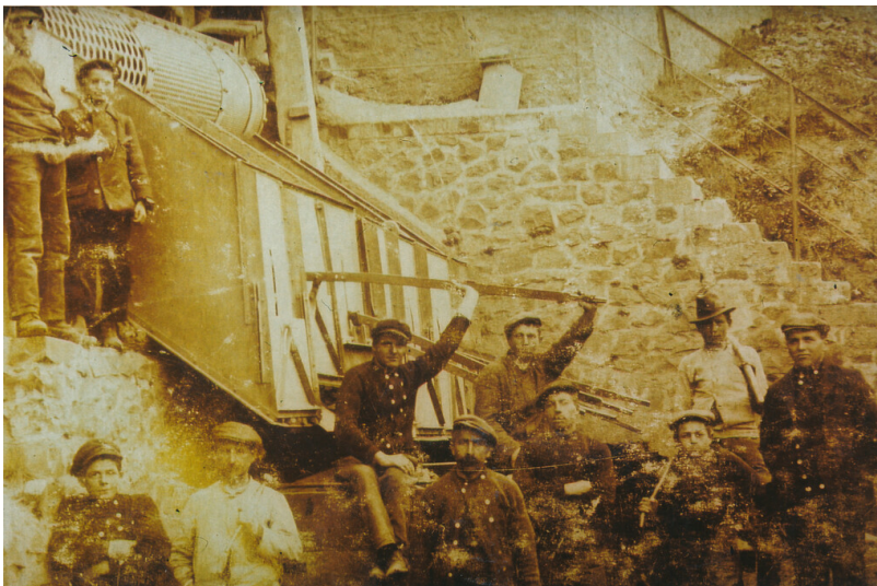
Steinbruch Limperichsberg: Steinbrecher der Fa. Adrian. Arbeiter an den Ladeklappen der Trommelsiebzanlage. So konnten die Waggons der Heisterbacher Talbahn direkt befüllt werden (um 1900). Fotograf/Urheber: unbekannt
