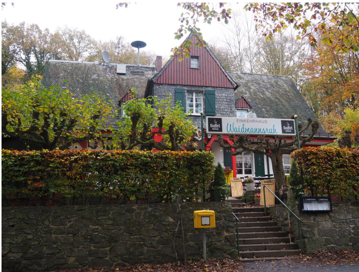
Einkehrhaus an der Rosenau (2024). Fotograf/Urheber: Joern Kling
