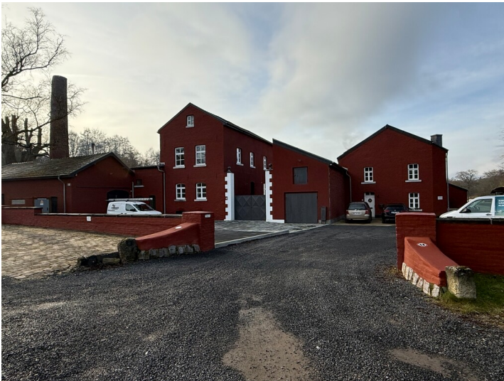
Komericher Mühle Gesamtanlage Fotograf/Urheber: Marius Röhr
