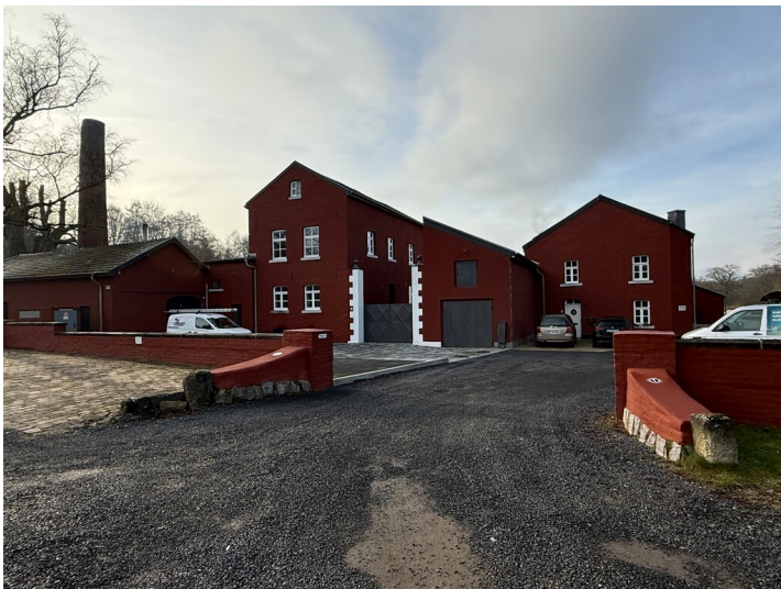
Komericher Mühle Gesamtanlage Fotograf/Urheber: Marius Röhr
