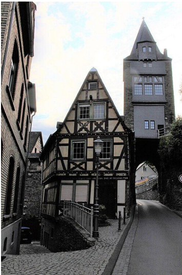
Das Fachwerkhaus Blücherstraße 39 und das Stadttor Steeger Tor in Bacharach (um 2020) Fotograf/Urheber: Peter62x
