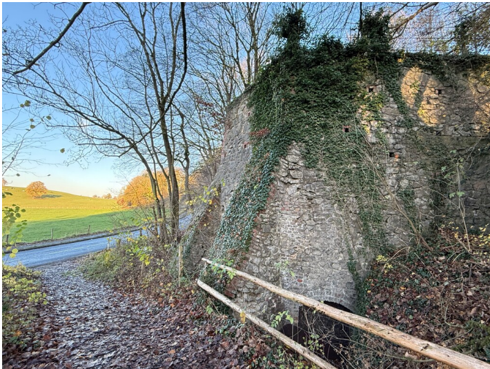
Südsicht auf den Kalkofen an der Bilstermühle Fotograf/Urheber: Marius Röhr
