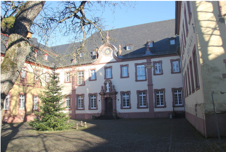
Prälatur des Klosters Steinfeld in Kall (2025). Fotograf/Urheber: Peter Burggraaff
