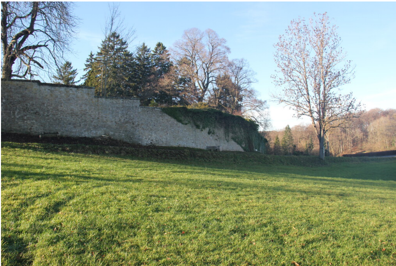
Außenseite der Klostermauer des Klosters Steinfeld (2025). Fotograf/Urheber: Peter Burggraaff
