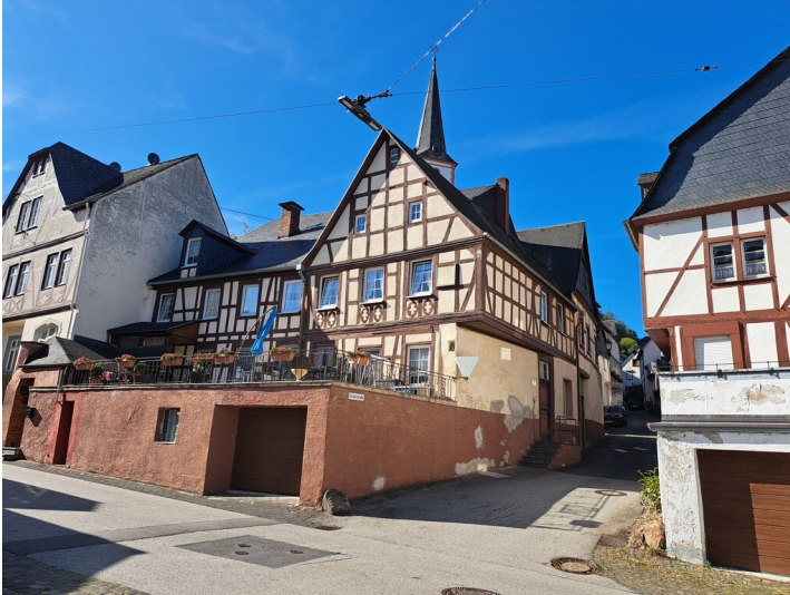
Fachwerkhaus Hauptstraße 89 in Briedel (2025) Fotograf/Urheber: Hermann Thur
