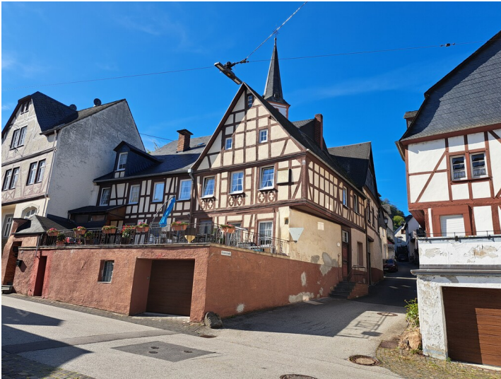
Fachwerkhaus Hauptstraße 89 in Briedel (2025) Fotograf/Urheber: Hermann Thur
