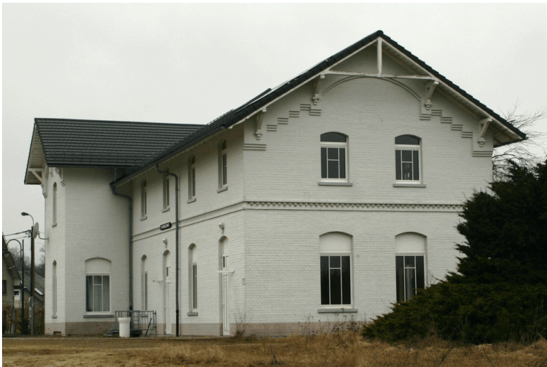
Bahnhof Waimes, Empfangsgebäude (2008) Fotograf/Urheber: Les Meloures
