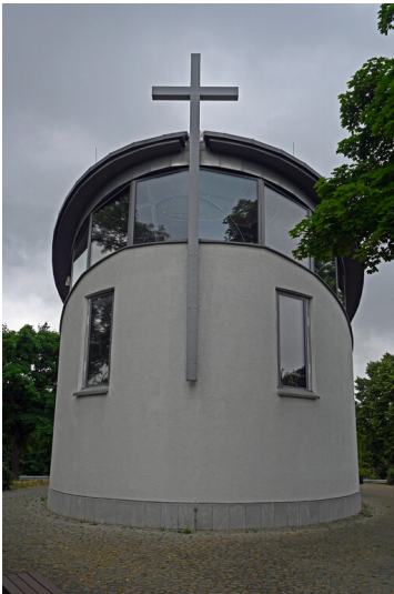
Autobahnkapelle Christophorus an der Kochertalbrücke (2025) Fotograf/Urheber: Karl Peter Wiemer
