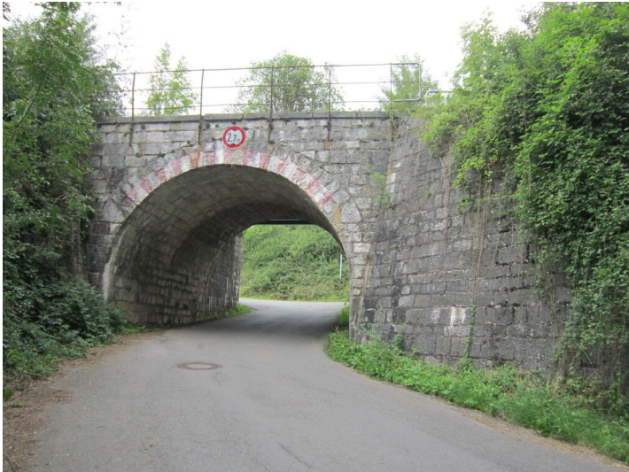
Das Bild zeigt die Eisenbahnbrücke über die Straße Knipp in Aachen-Hahn. Vennbahn und Strecke Herbstal - Stolberg (2014) Fotograf/Urheber: Claus Weber
