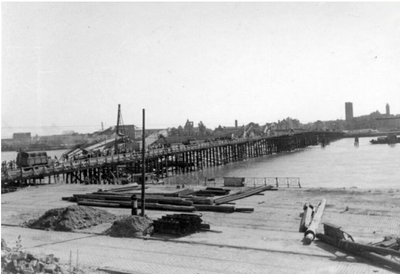
Historische Aufnahme der "Lt. Gen. Lesley McNair Bridge", einer Kölner Behelfsbrücke zwischen der Altstadt und Deutz nach dem Zweiten Weltkrieg (1945/47). In Blickrichtung nach Deutz hin ist rechts die zwischen 1943 und 1945 erheblich beschädigte Kirche Sankt Heribert zu erkennen. Fotograf/Urheber: photograph
