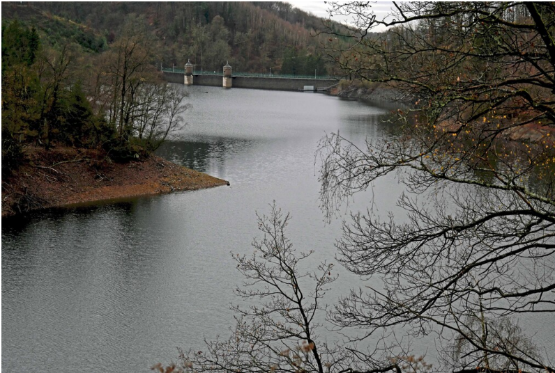
Sengbachtalsperre in Solingen (2025) Fotograf/Urheber: Karl Peter Wiemer
