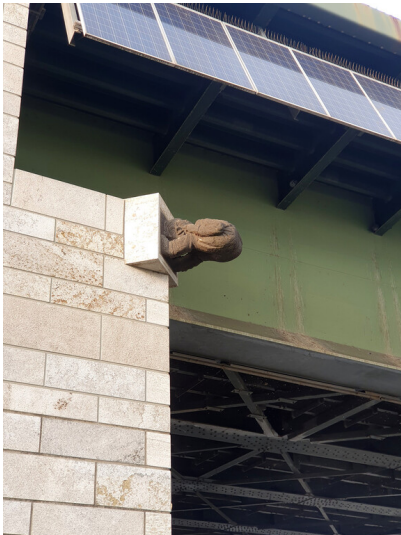
Brückenmännchen am rechten Brückenpfeiler der Kennedybrücke in Bonn (2025). Fotograf/Urheber: Jana Schulte
