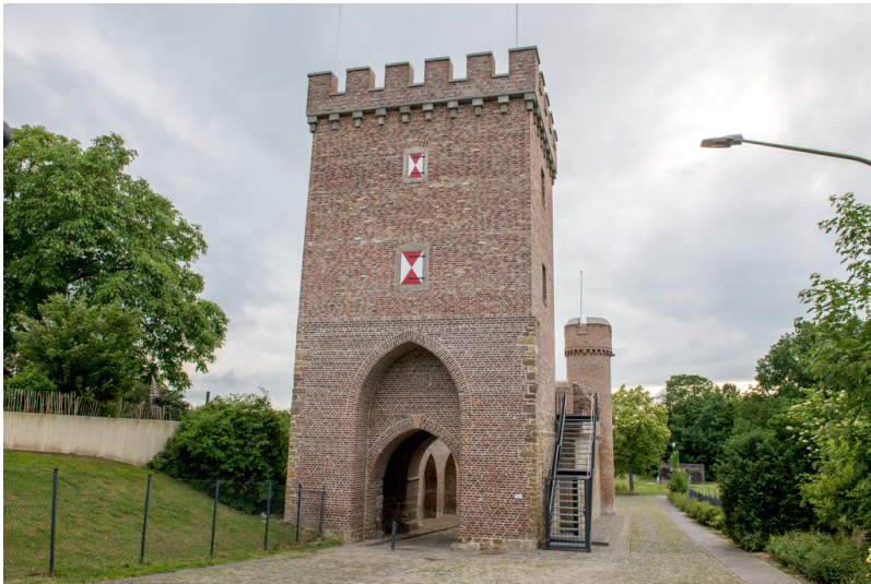
Zülpich. Das Weiertor des Spätmittelalters, 2024 umfangreich saniert. Das Haupttor gegen Westen. Fotograf/Urheber: Marcel Zanjani / LVR-Amt für Bodendenkmalpflege im Rheinland
