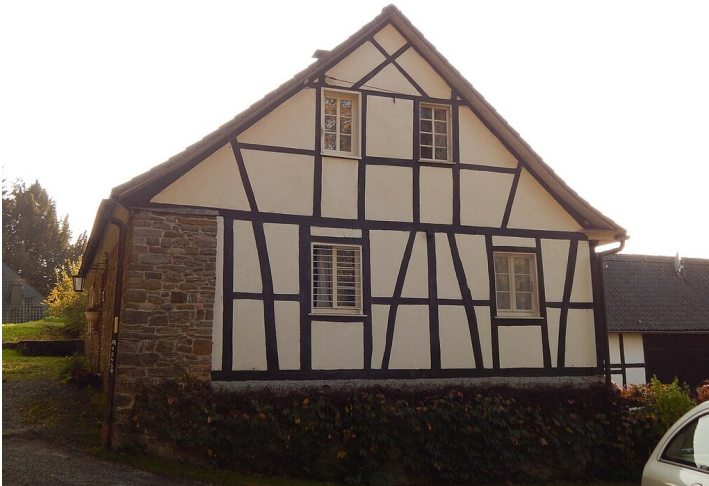
Wohnhaus des Rentmeisters von Schloss Ehreshoven mit Giebelseite in Fachwerkbauweise (2014) Fotograf/Urheber: Duschan1944
