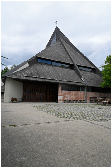
Autobahnkirche Windach (2025) Fotograf/Urheber: Karl Peter Wiemer
