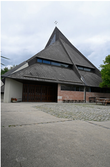
Autobahnkirche Windach (2025) Fotograf/Urheber: Karl Peter Wiemer
