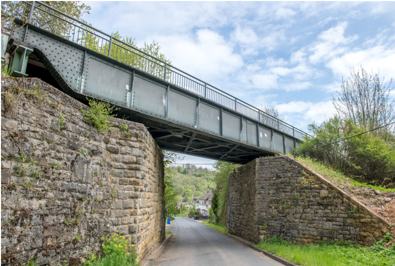
Dahlem-Kronenburgerhütte. Ehemalige Eisenbahnbrücke der Vennquerbahn. Fotograf/Urheber: Marcel Zanjani / LVR-Amt für Bodendenkmalpflege im Rheinland
