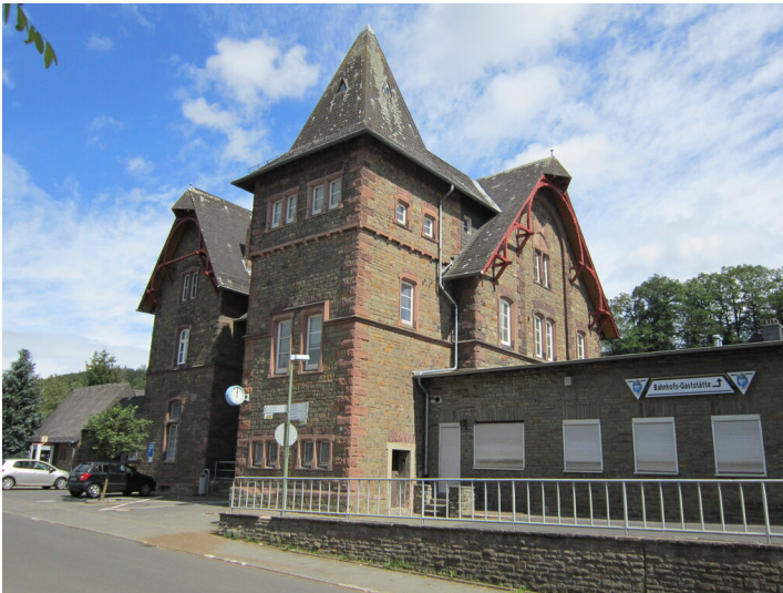
Bahnhof Jünkerath (2012) Fotograf/Urheber: Claus Weber
