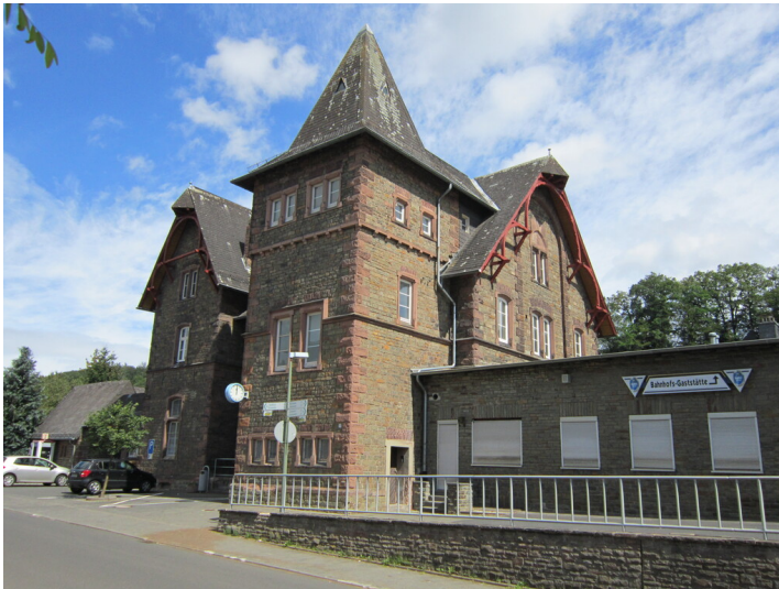
Bahnhof Jünkerath (2012) Fotograf/Urheber: Claus Weber
