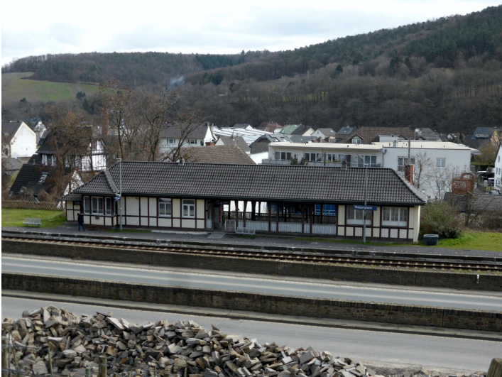
Bahnhofsgebäude am Haltepunkt Walporzheim der Ahrtalbahn (2023) Fotograf/Urheber: Elmar Knieps
