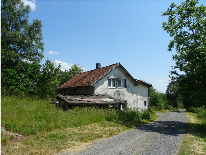
Das ehemalige Maschinenhaus des Frühlingsschachtes bei Rösrath (2023). Fotograf/Urheber: Peter Schönfeld
