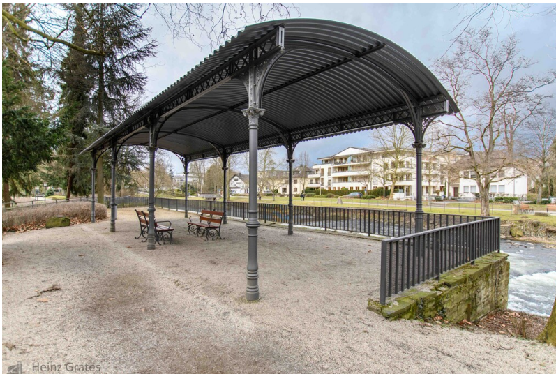
Historische Wandelhalle im Kurpark Bad Neuenahr (2017) Fotograf/Urheber: Heinz Grates
