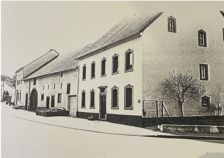
Schrägsicht vom Trappenhaus in der Bitburger Straße 8 in Oberkail (um 1980) Fotograf/Urheber: unbekannt
