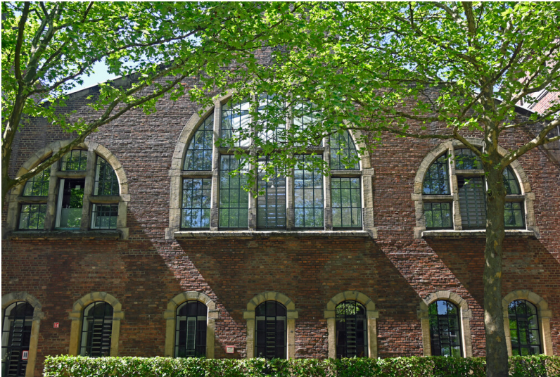
Zeche Rheinpreussen in Moers, Schacht V (2025) Fotograf/Urheber: Karl Peter Wiemer
