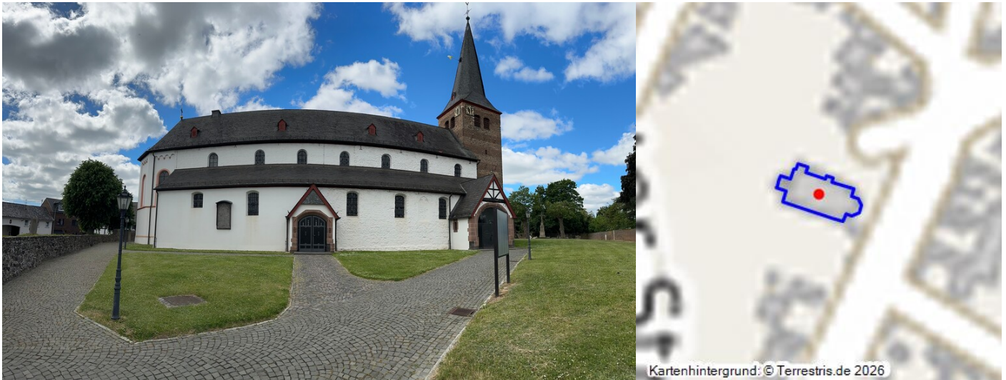
Die Pfarrkirche Sankt Pankratius in Lommersum vom Zugang durch den Torbogen am Spanischen Platz gesehen (2025). Fotograf/Urheber: Lea Recken
