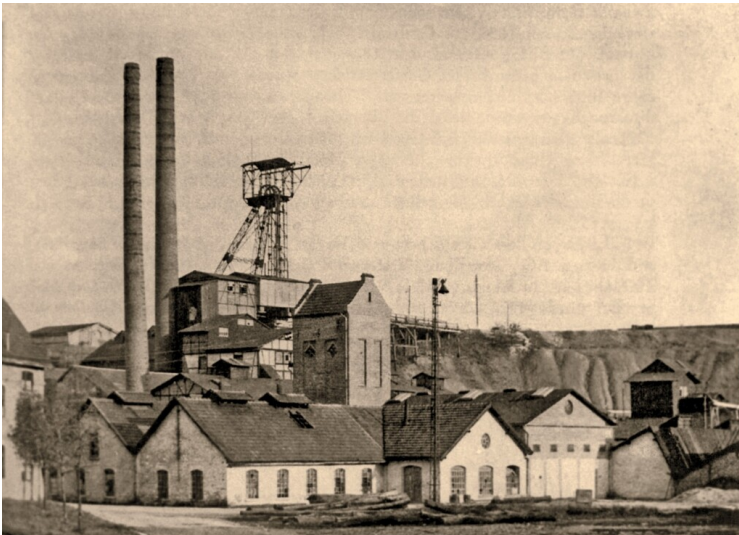
Aufbereitung und Transformatorenhaus der Grube Weiß in Moitzfeld (um 1928) Fotograf/Urheber: unbekannt
