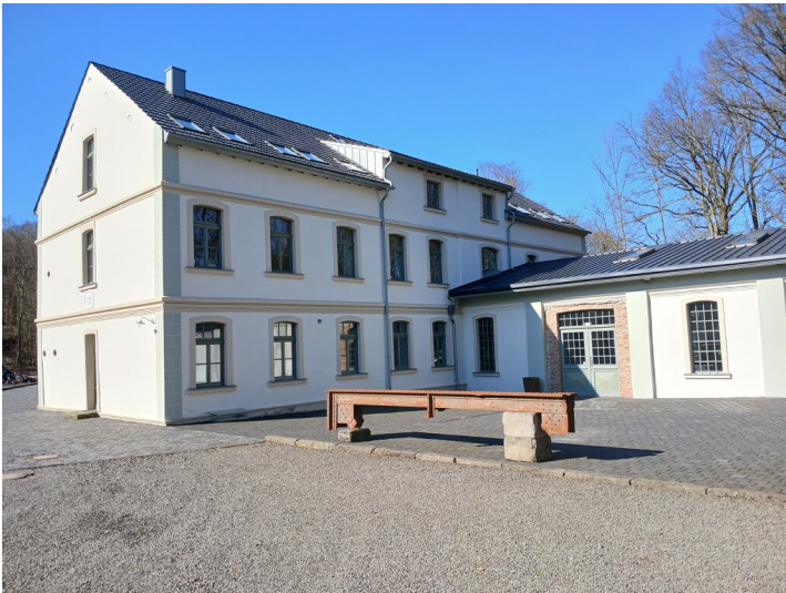
Verwaltungsgebäude und Magazin der Grube Weiß in Moitzfeld (2025). Fotograf/Urheber: Alexander Kierdorf
