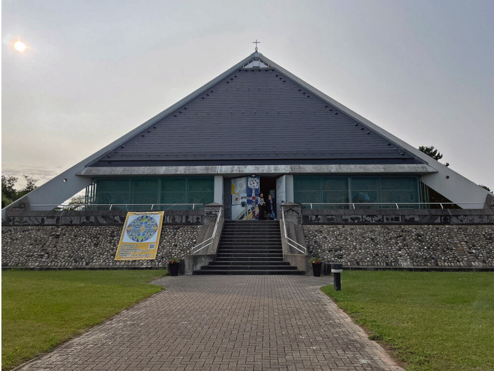
Autobahnkirche Baden-Baden (2025) Fotograf/Urheber: Leonie Wiemer
