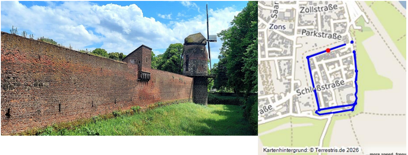
Die Stadtmühle Zons an der Süd-West-Ecke der Stadtmauer der Zollfeste Zons (Feste Zons), heute Stadtteil Dormagen-Zons (2022).
