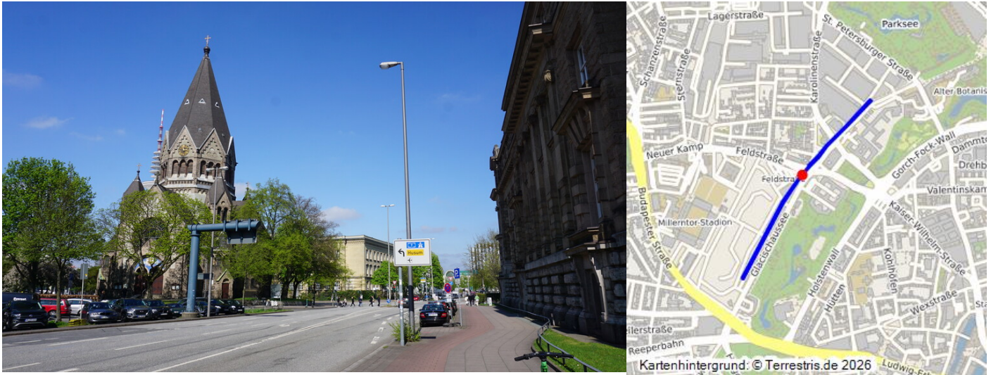
Hamburg, Trasse Magnetschwebebahn Holstenglacis (2025) Fotograf/Urheber: Claus Weber
