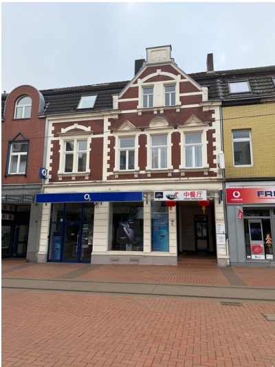
Wohn- und Geschäftshaus Johann Balkhausen (2025) Fotograf/Urheber: Nicole Schmitz
