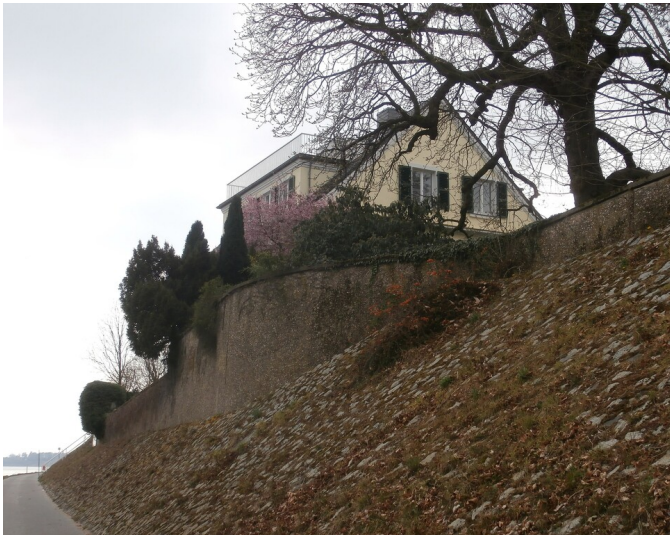
Das 1872 erbaute Herrenhaus des Dietkirchener Hofes in Wesseling-Urfeld, Ansicht vom Rheinufer aus (2014). Fotograf/Urheber: Leit
