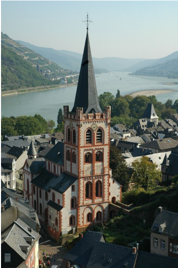
Die evangelische Kirche St. Peter in Bacharach (2005) Fotograf/Urheber: Peter Weller
