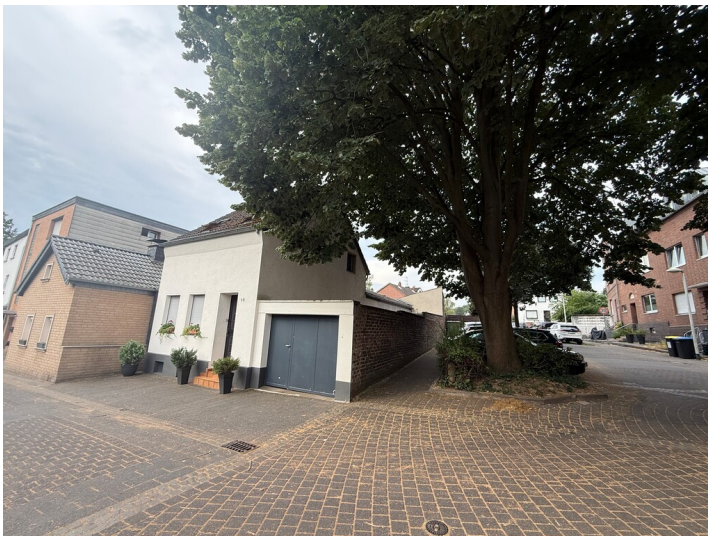
Straßeneinmündung Jägerstraße / Rinkenpfuhl mit Töpferwohnhaus (2026) Fotograf/Urheber: Nicole Schmitz
